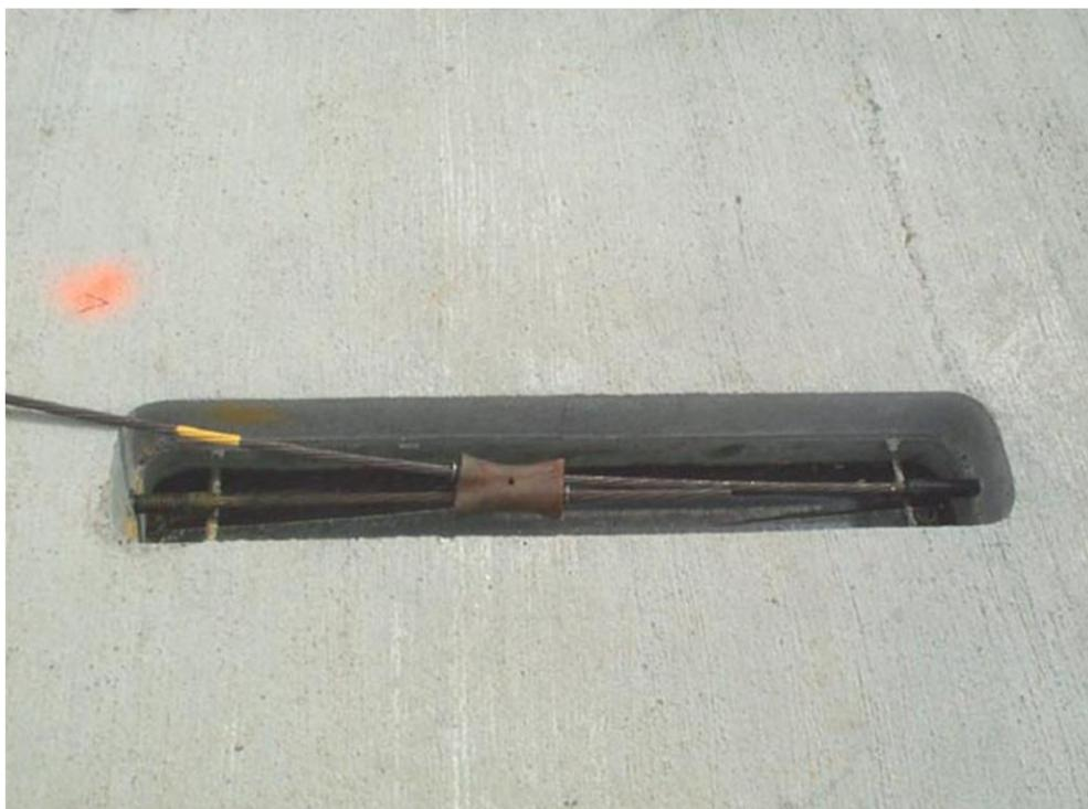
Рис.6. Вид крепежной пустоты после напряжения и скрепления стальных канатов двунаправленным анкером перед ее омоноличиванием
