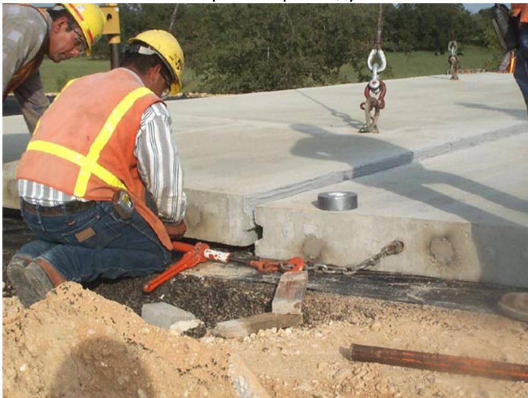
Рис.4. Установка железобетонной плиты сборного типа
