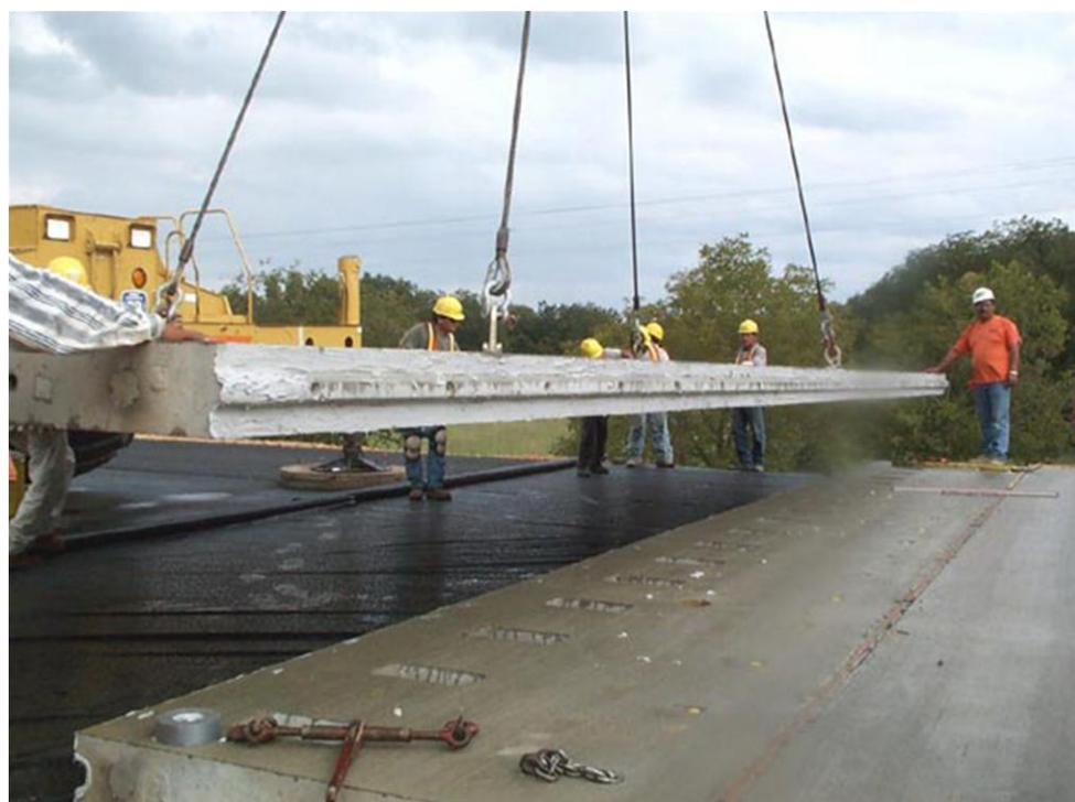
Рис.7. Подача бетонной плиты сборного типа на дорожное земляное полотно с подсыпкой дренирующего песчаного слоя, укрытого полиэтиленовой пленкой
