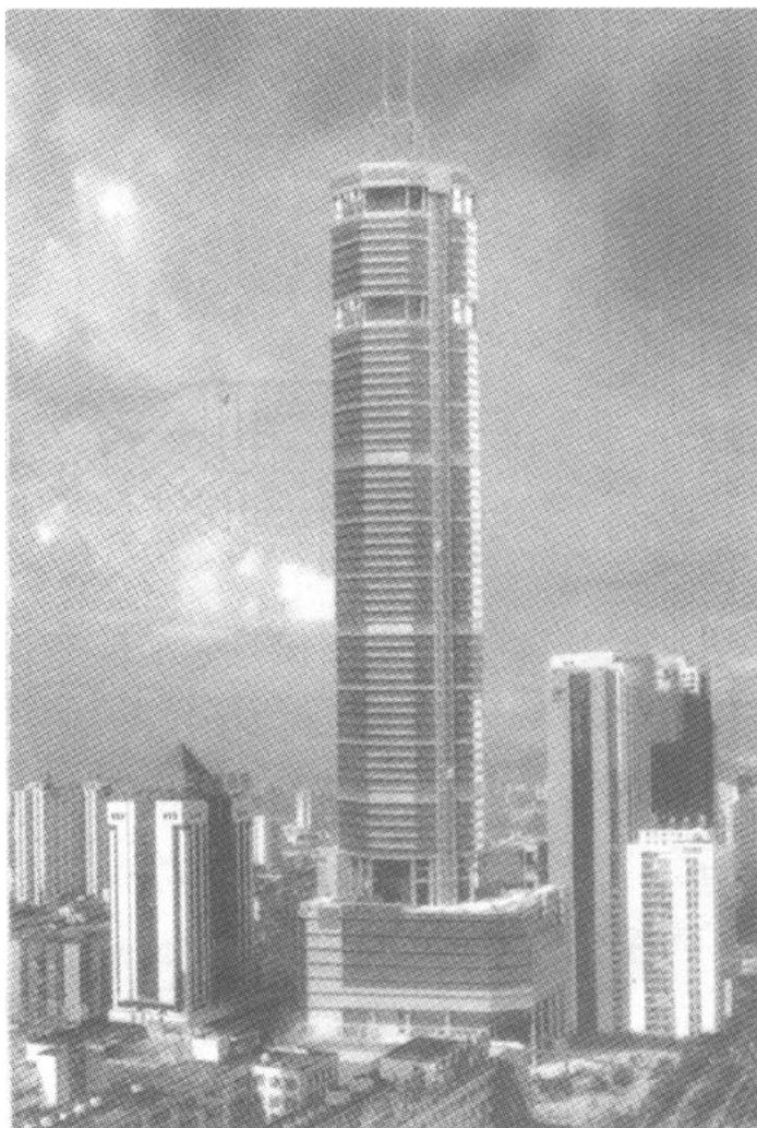
Рис. 1. Здание с каркасом из трубобетона на площади Сайгэ в Шэньчжэне, КНР (72 этажа)
