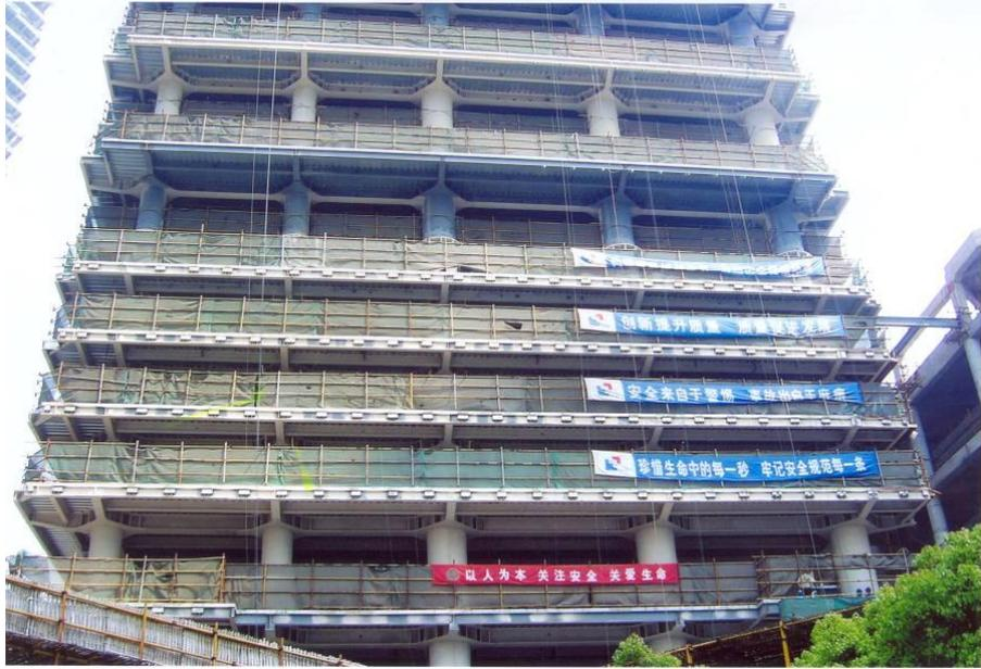
Рис.2 Дом в г.Пекин строящийся с применением трубобетонных колонн
