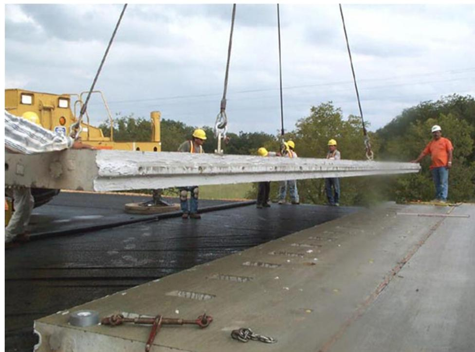
Подача бетонной плиты сборного типа на дорожное земляное полотно с подсыпкой дренирующего песчаного слоя, укрытого полиэтиленовой пленкой
